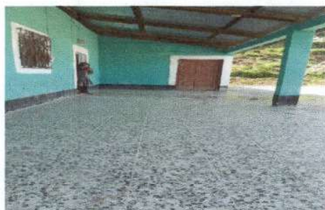
Foto3: Finalización del piso de granito.
