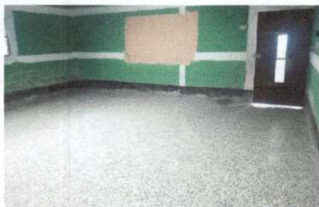
Foto1: Finalización del piso de granito.
