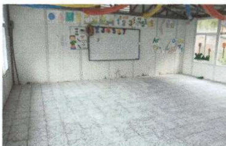
Foto5: Finalización del piso de granito.
