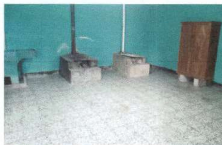
Foto2: Finalización del piso de granito.
