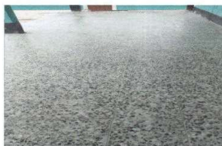
Foto4: Finalización del piso de granito.
